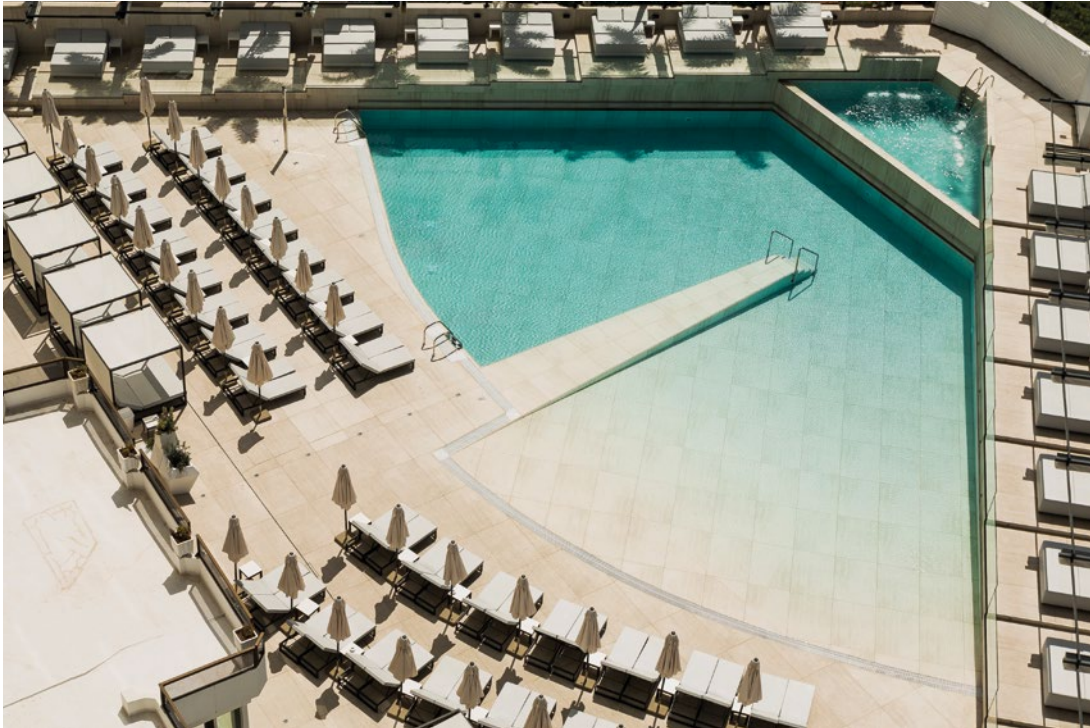
TECHLAM® Strattos Hotel Caserio Gran Canaria, Espanha
